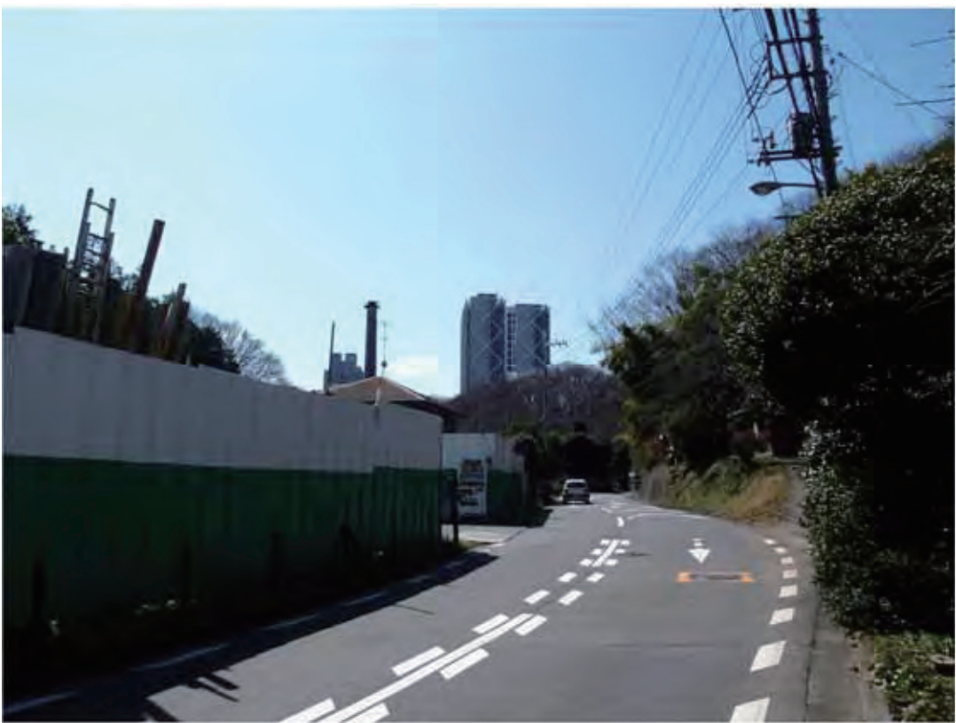
写真 4.4-2 ②セントラルハウス付近
